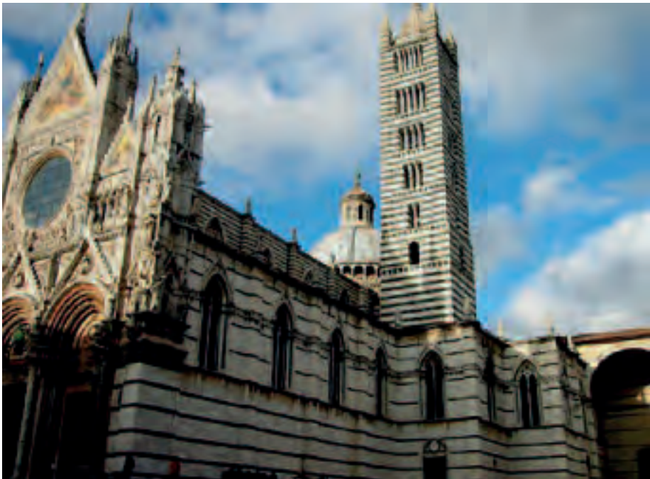
13. Duomo di Siena: le parti verde scuro sono costituite da liste del cosiddetto “marmo nero di Vallerano”, che in realtà è una serpentinite massiva proveniente dalle cave della zona di Murlo
