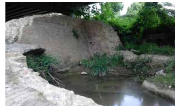
Fig. 3 – Parte frontale della diga antica sul Tressa.
