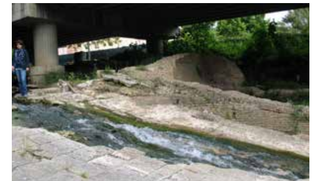
Fig. 4 – La diga antica con l’annesso scivolo lastricato.
